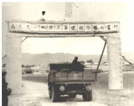
满载建筑材料的车开进工地
