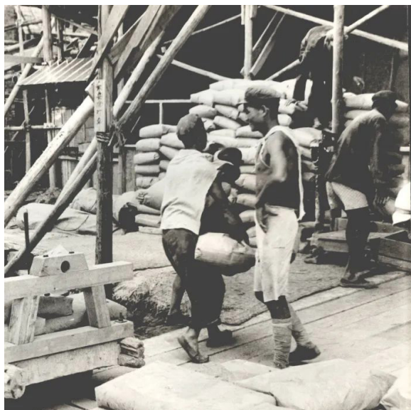
热火朝天的施工现场
