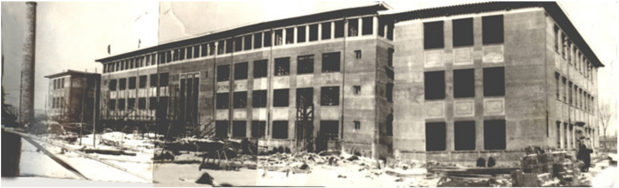
完工后的一号楼
